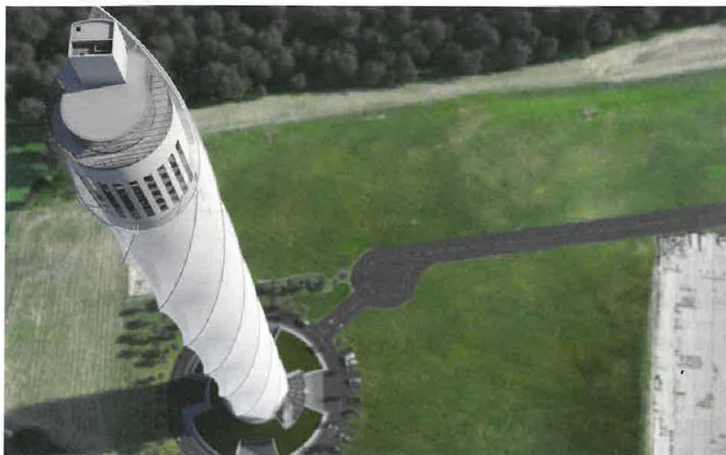
Thyssenkrupp hat in Rottweil den höchsten Aufzugstestturm Europas gebaut. Seit einem Jahr wird hier bereits geforscht und geprüft
