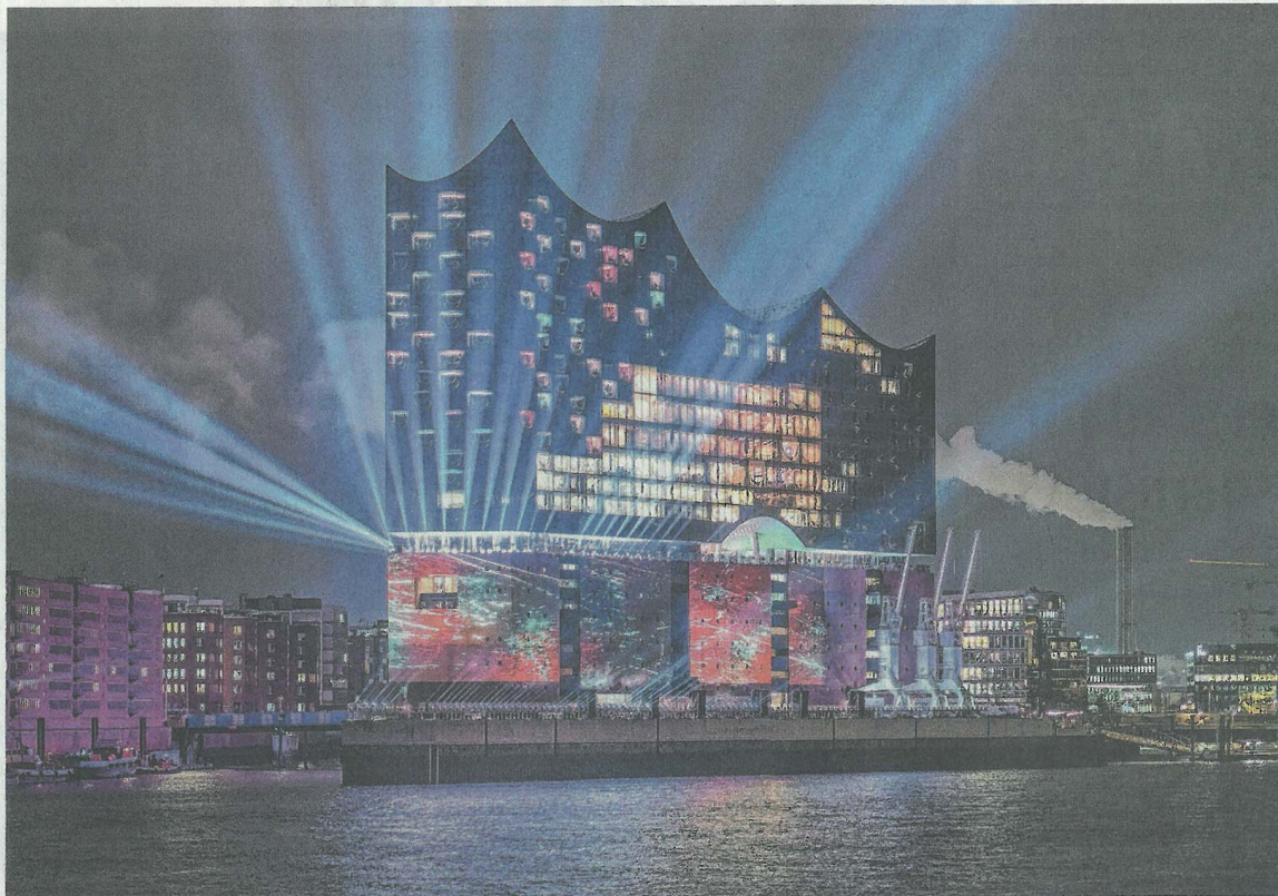
Spektakulär: Die Elbphilharmonie ist nach zehn Jahren Bauzeit feierlich eröffnet worden. Für Gebäudeautomation und Raumklima in Hamburgs neuem Wahrzeichen wurde Technik „Made in Verl“ eingebaut.
