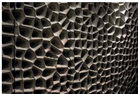
Die „Weiße Haut“ sorgt für optimale Akustik und besteht aus insgesamt 10.000 Gipsfaserplatten.
